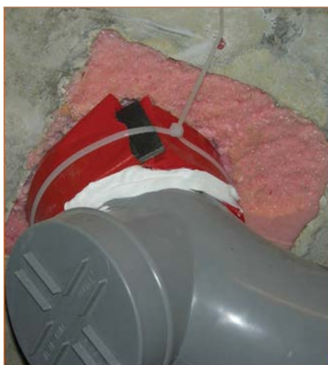
Improper use of PU foam
